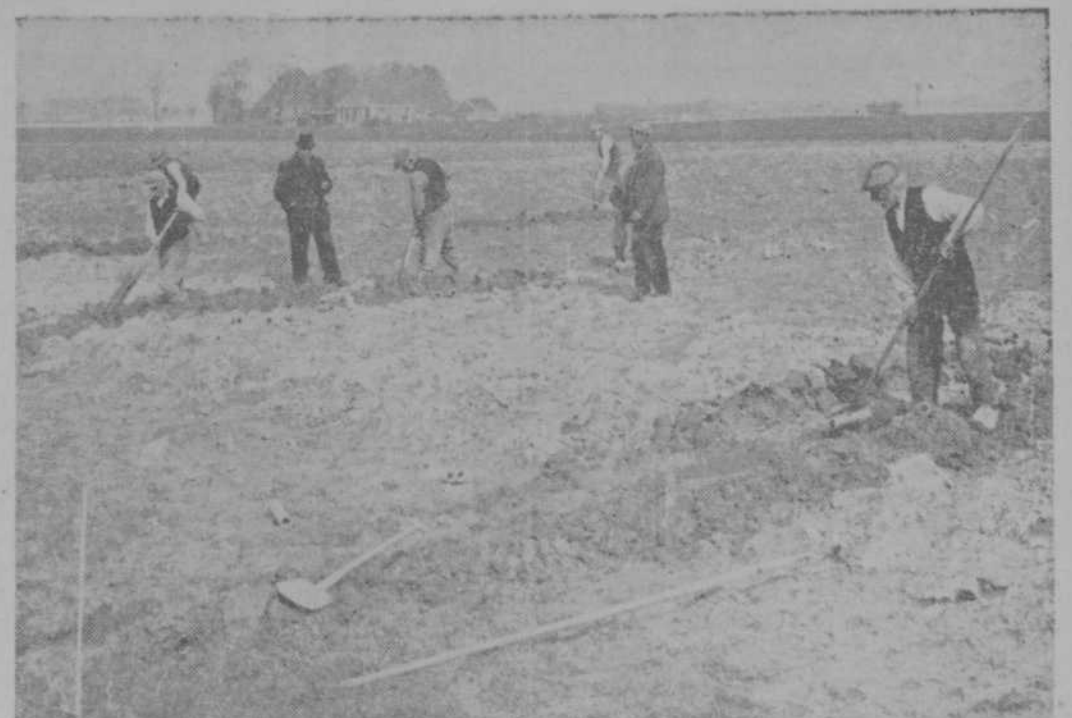
MET MEDEWERKING VAN DE NED. HEIDEMAATSCHAPPIJ is men er in de Friese kleistreek bij Witmarsum toe overgegaan verschillende stukken grond, waar de afwatering te wensen laat, te draineeren. Onder deskundige leiding graven arbeiders de geulen, waarin de draineerbeuizen komen te liggen.
