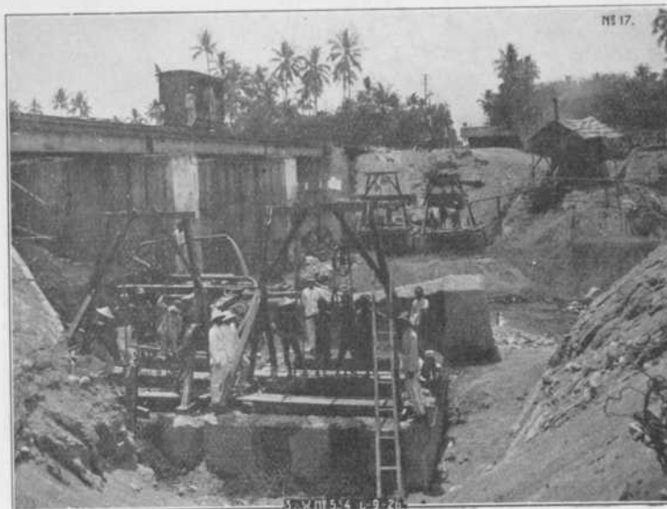
Afb. 17. Het laten zakken der sinkputten van de nieuwe landhoofden.
