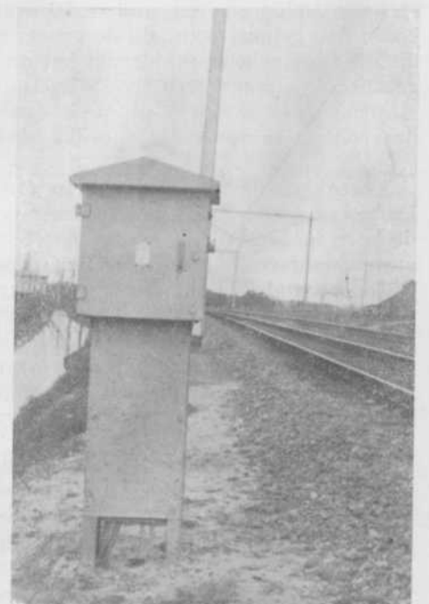
Afb. 7. Aftakkast met transformator 1500/200 Volt: links aansluiting hoogspanningszijde; midden laagspanningszijde voor aansluiting naar relaiskast; rechts uitwendig.
