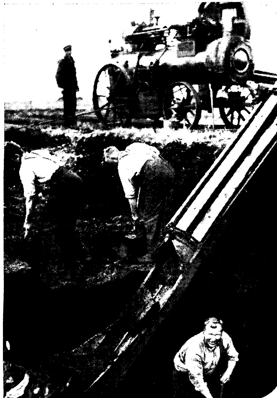
DE TURFCAMPAGNE IN HET VEEN bij Emmererfseidevenen en omgeving is thans in vollen gang. * Rechts: De pers- turfmachines draaien op volle kracht. * Links: De tot een turfhoogte opgespoten bagterturf wordt in strepen verdeeld om vervolgens met het turfmes gesneden te worden.
