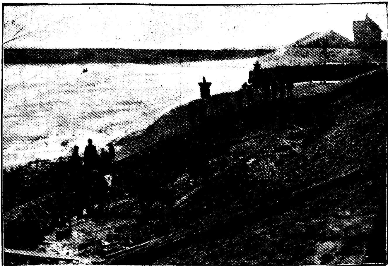
Tengevolge van den storm der laatste dagen verzakte een groot gedeelte van den weringmuur aan de Scheveningsche haven. Het herstellingswerk.
