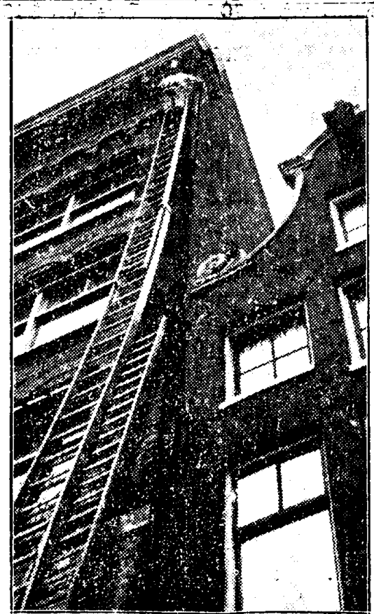
De gevelklimmer, die een nieuwe afvoerbus langs den gevel van een der Amsterdamsche fabrieksgebouwen moest bevestigen
