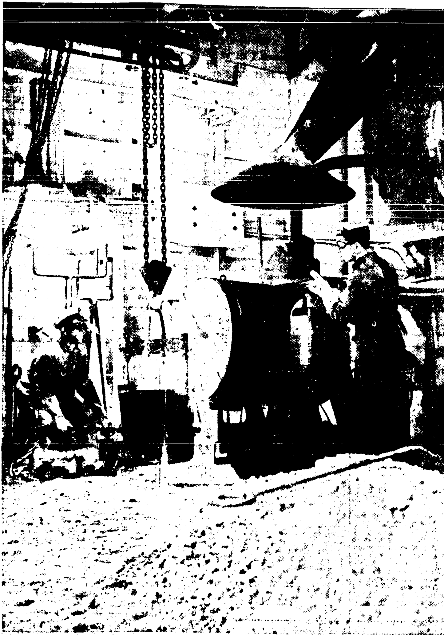
De „Forth“, het kortelings in dienst gestelde reparatieschip voor onderzees der Britsche vloot. Een gezicht op een der reusachtige werkplaatsen
