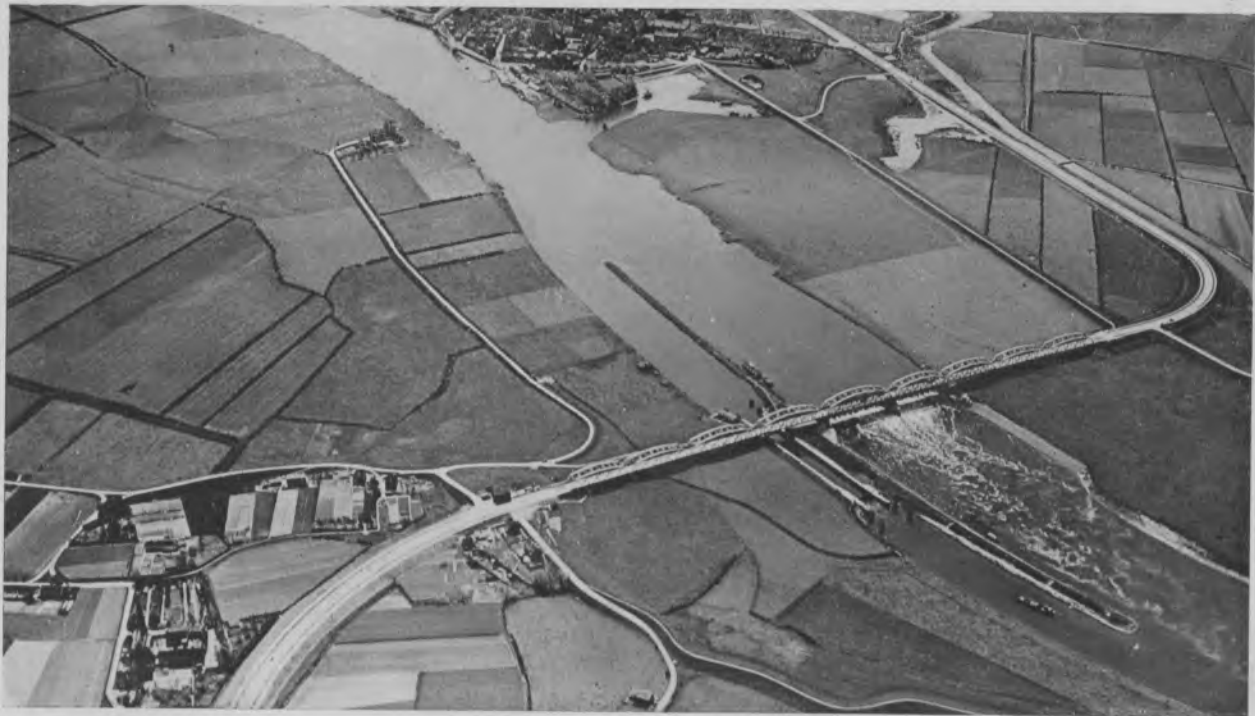
De Rijksweg, de Maasbrug, de Rivier de Maas en de stad Grave vanuit de lucht.
