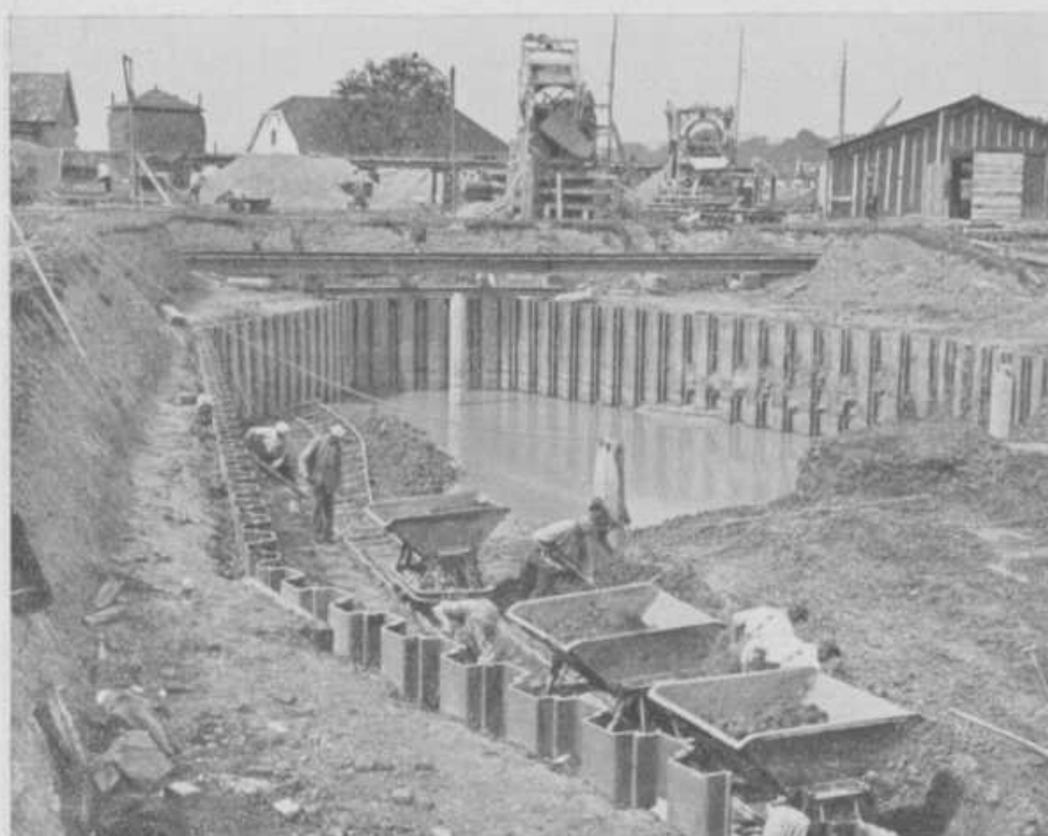
LARSEN-DAMWAND VOOR FUNDEERING RIJNBRUG TE ARNHEM
