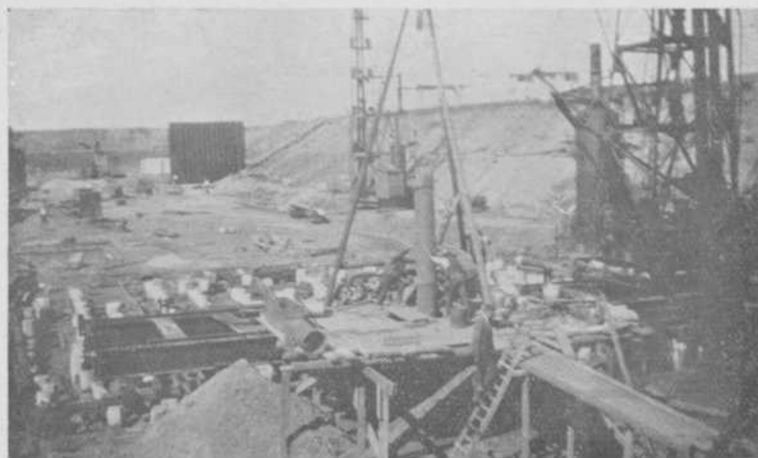
Het boren van een bronbemaalingsput bij den bouw der schutsluis te Born.
