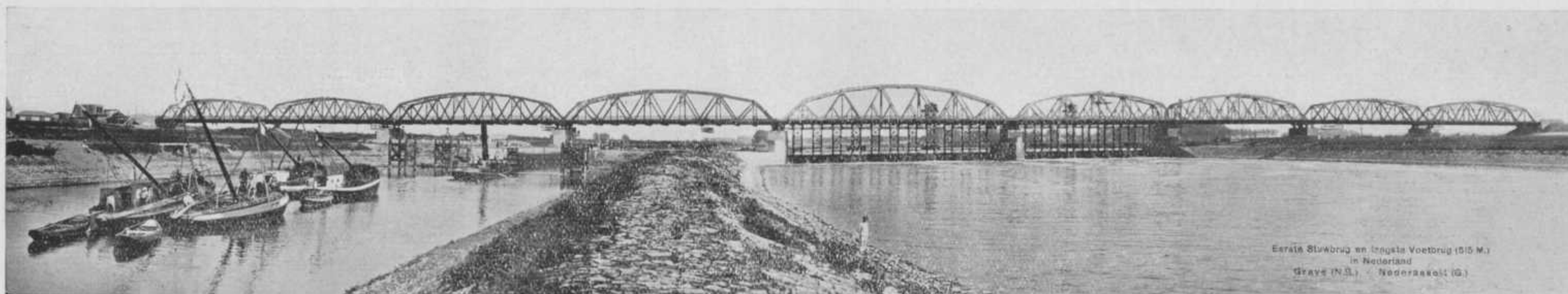
Stuwcomplex met Maasbrug te Grave; eindpunt der eigenlijke kanalisatiewerken.
