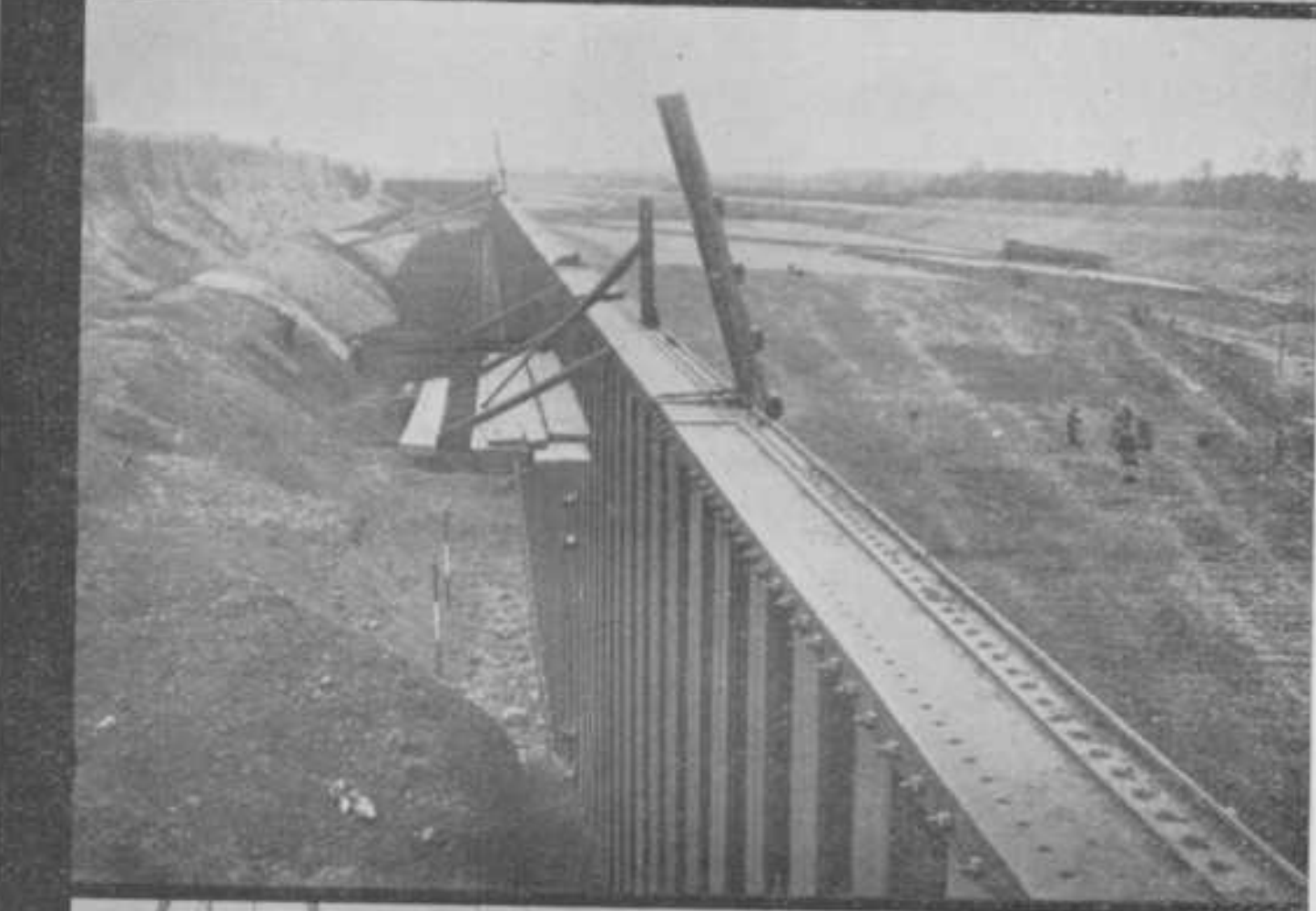
245 M. kademuur in den kolenlaadhaven te Stein nabij Maastricht aan het Julianakanaal met gebruikmaking van het Klöckner-profiel 5 D, lengte 17,50 M.
