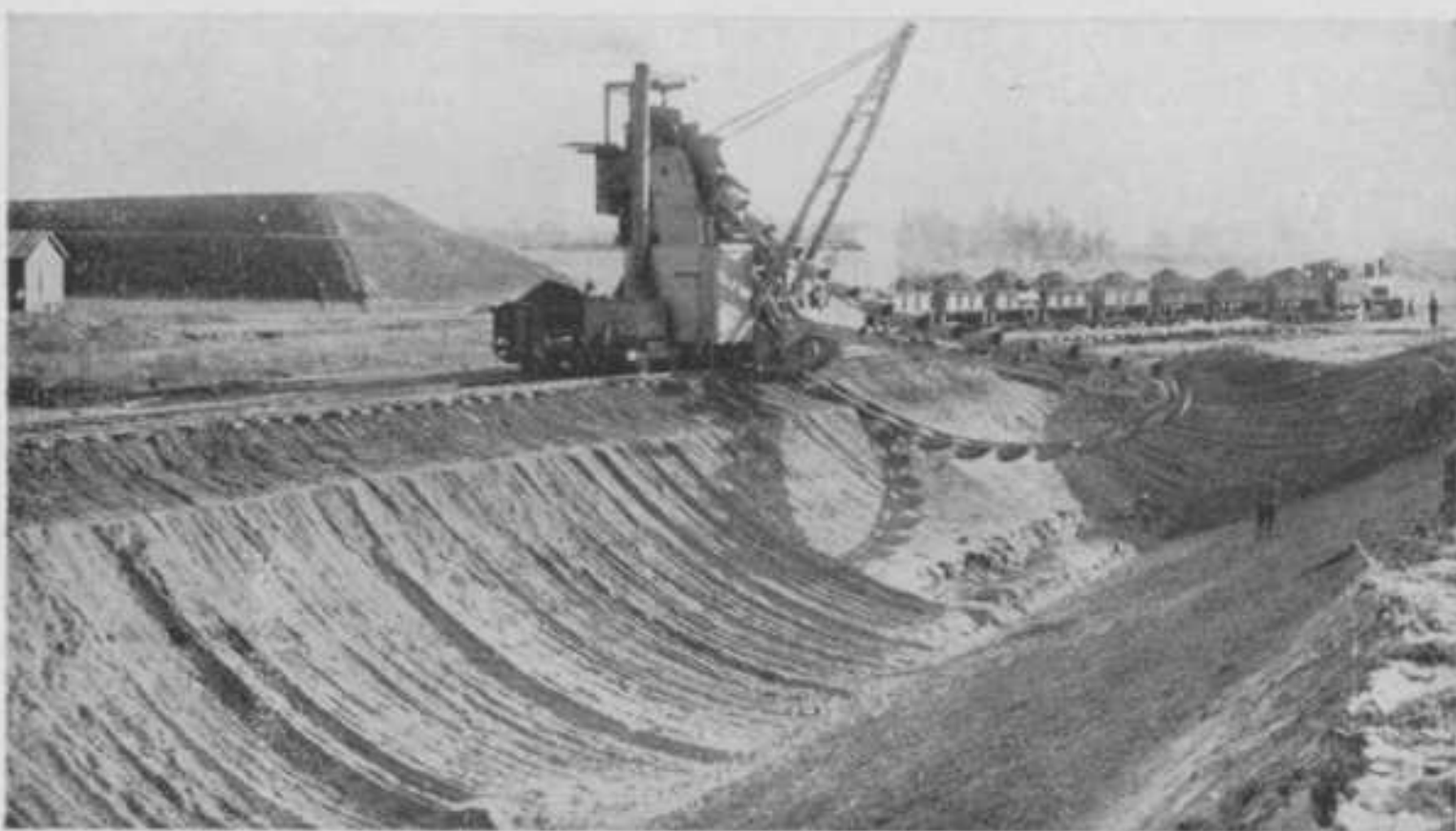
Wording: Grondwerken aan het Julianakanaal door de N.V. voorheen T. den Breejen van den Bout.
