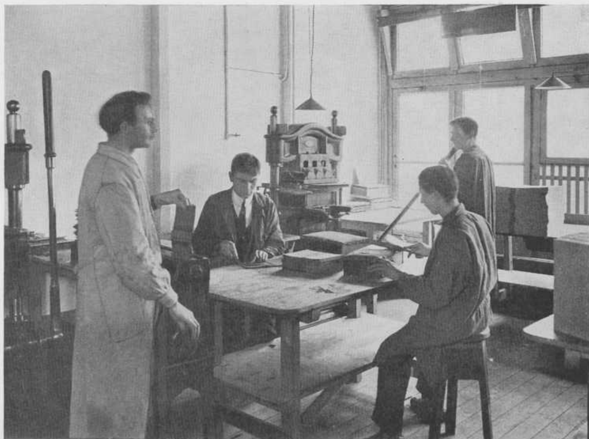
De verguldpers. Op den voorgrond ziet men 2 zittende personen, waarvan de een het goud op het kussen toesnijdt, de ander het op den boekband legt. Op den achtergrond ziet men het overhalen van den hefboom der pers. De band met het opgelegde goud wordt op de slede gelegd, deze ingeschoven, waarna de perstafel tegen de stoof wordt aangedrukt, aan welke laatste de stempel of het lettermateriaal is bevestigd. De pers is voor gouddruk verwarmd. Van de juiste hitte is afhankelijk de diepe glans en de duurzaamheid van den gouddruk. Links op den voorgrond ziet men het afschuiëren van overtollig goud.
