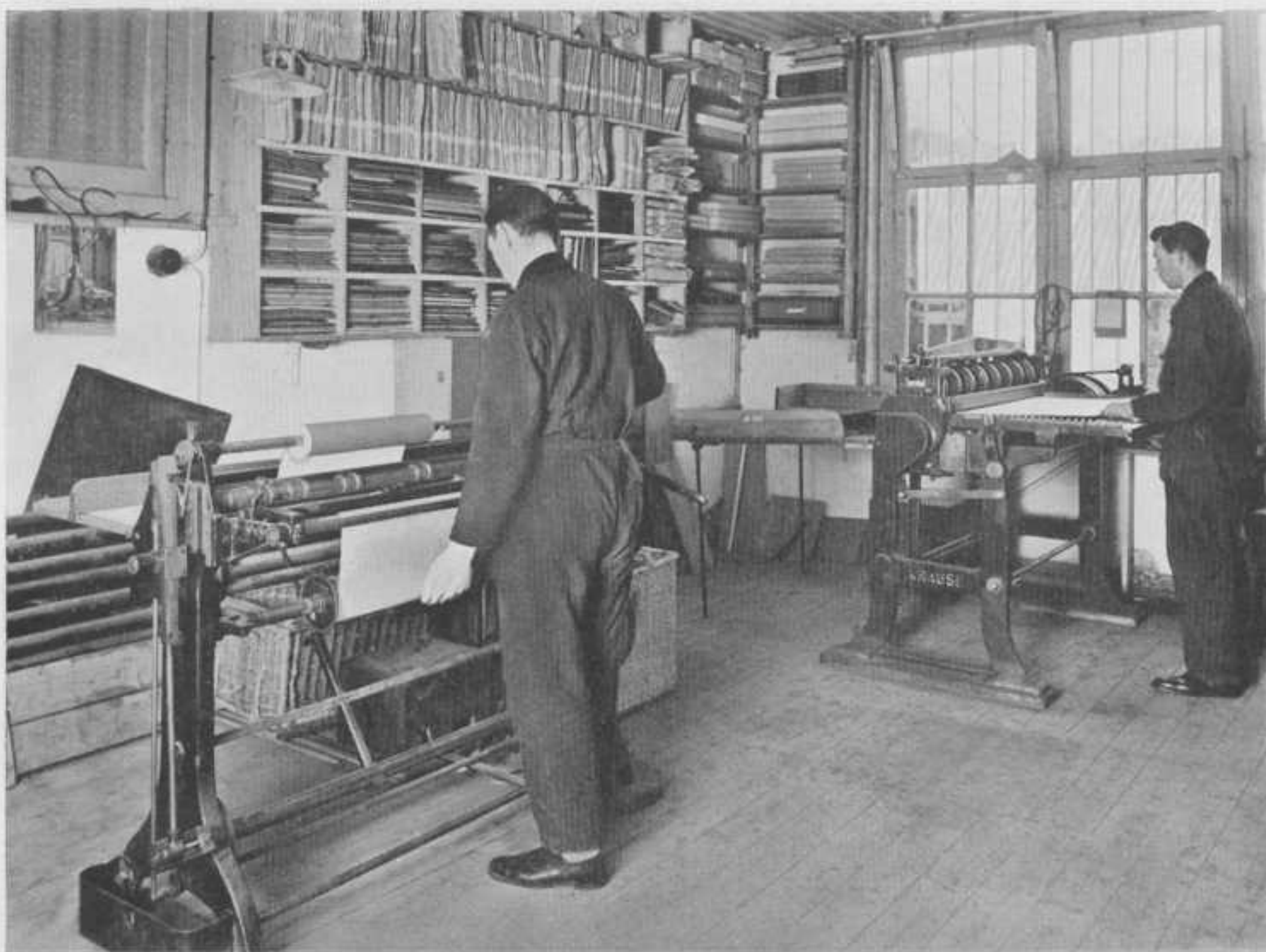
Het toesnijden van materiaal. Rechts ziet men hier het snijden van het bordpapier. De vellen bord worden in de machine gebracht en door ronde messen aan strooken op het juiste formaat gesneden. Op den voorgrond ziet men het automatisch snijden van het linnen, waartoe een speciale machine op verschillende maten kan worden gesteld, en in één doorgang het materiaal op juiste breedte en lengte afsnijdt.
