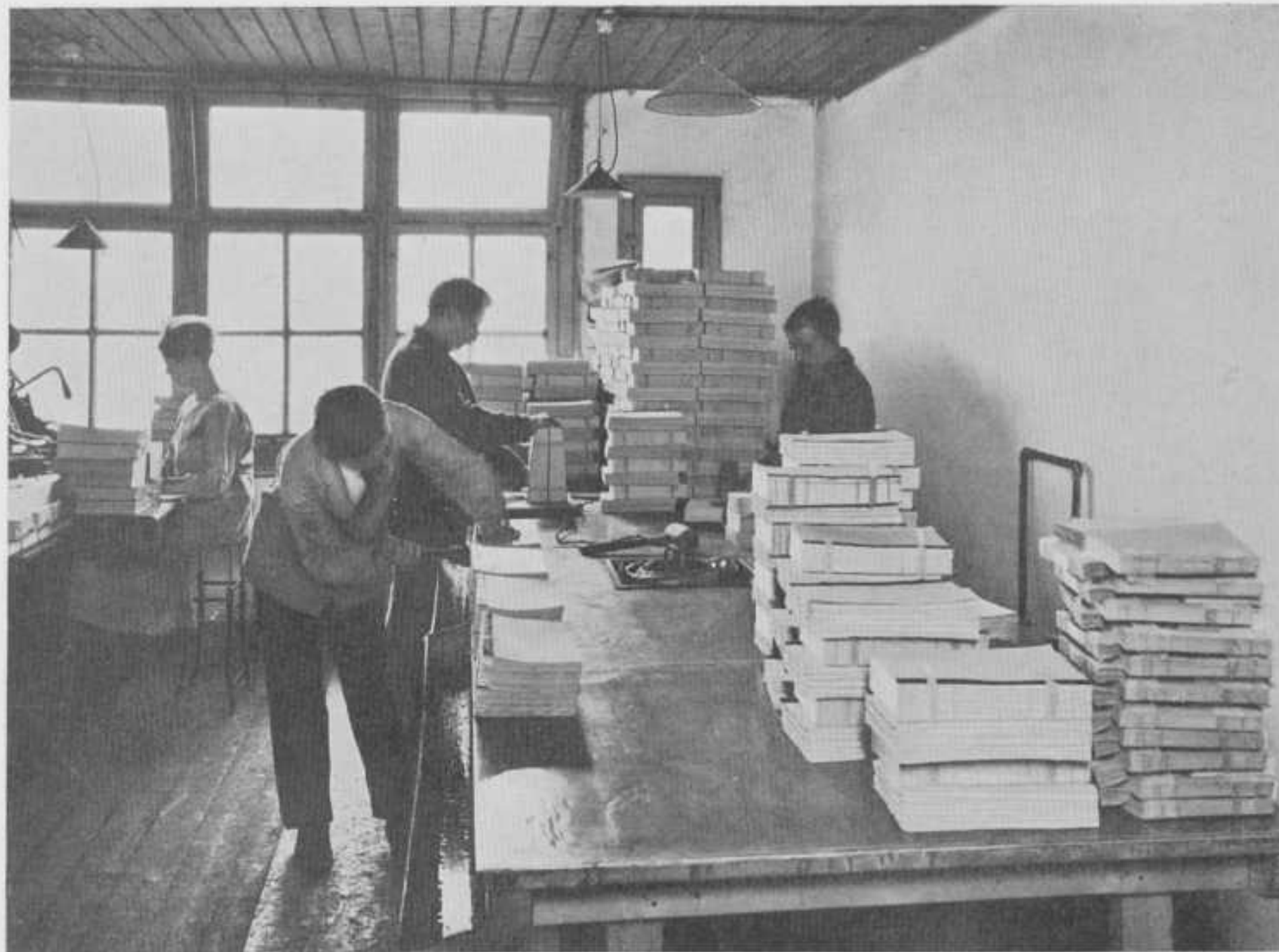
Het lijmen der boeken. Nadat de boeken genaaid zijn, worden de ruggen gelijmd, waartoe een speciale tafel met zink bekleed en voorzien van een goot voor het opvangen der lijmspatten, noodig is.
