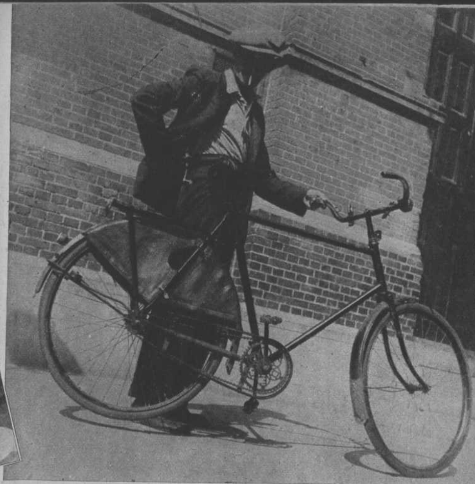
WAT „HIJ” DOET: ....en zelfs als Uw fiets op slot staat is zij lang niet veilig. Ziehier een gaarne toegepaste truc. Een truc met een haak aan den schouder, de haak aan den bagagedrager, achterwiel optillen, wegrijden.... De haak blijft onder het jasje verborgen!
