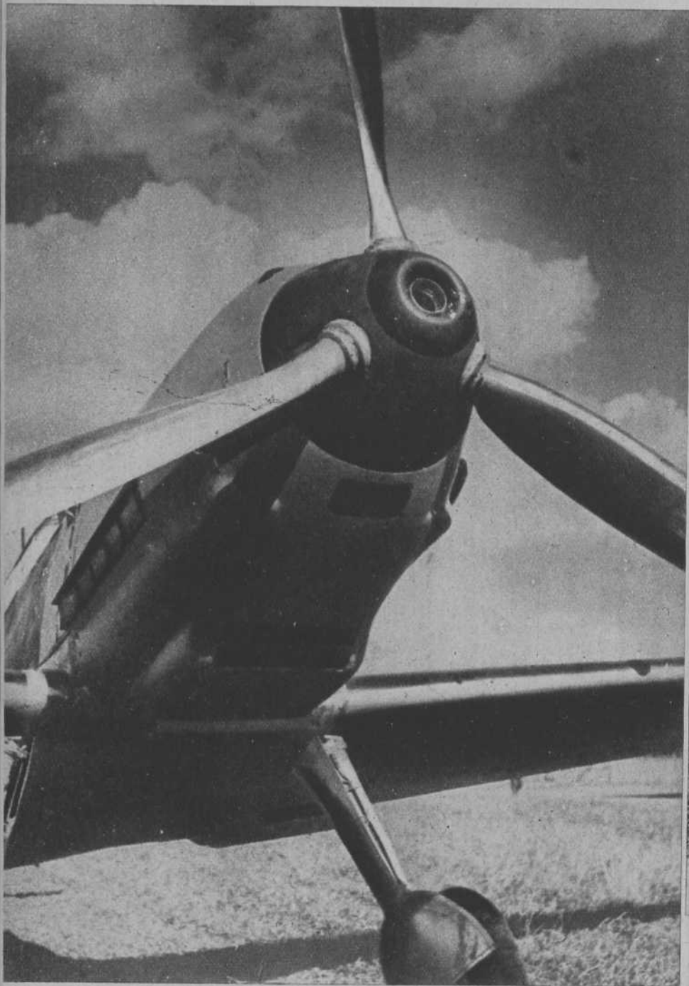
Vooraanzicht van de Me 109. Behalve eenige mitrailleurs in de draagvlakken en in de cockpit heeft het toestel een kanon, waarvan de loop door de kern van den propeller is geleid.
