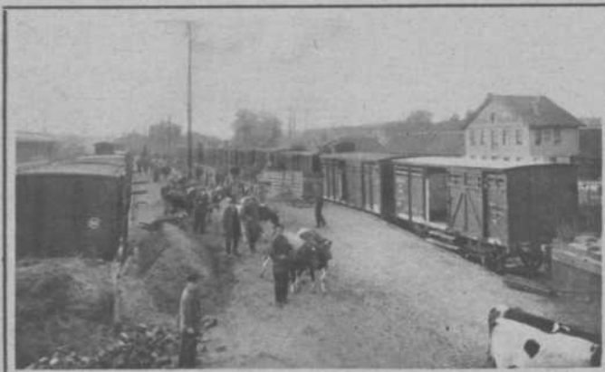
Dat de afdeling veelalading bij het drukke spoorwegcentrum Utrecht van groote beteekenis is, zal men zich gemakkelijk kunnen voorstellen. We geven er hier een overzichtsfoto van.
