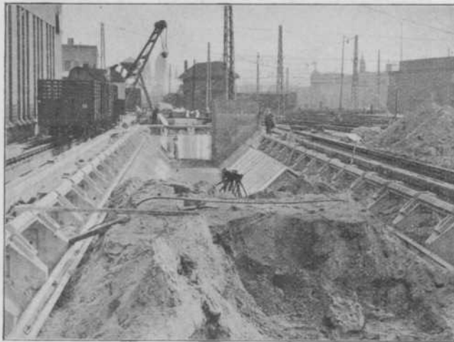
Afb. 4. Montage op het terrein. De stoomwagenkraan is op het linker spoor te zien.
