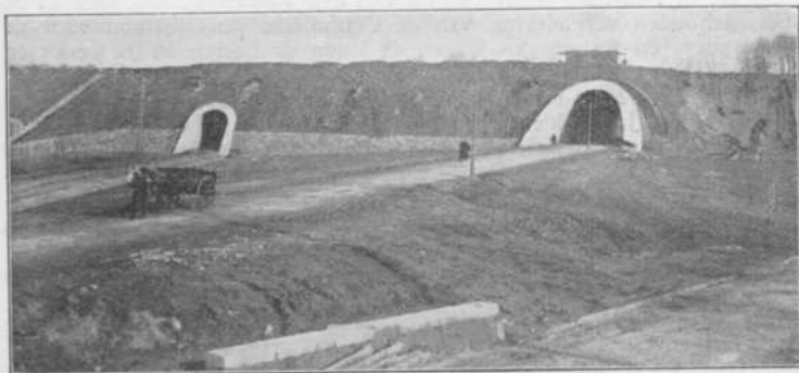
Links de tramtunnel van de lijn Heerlen—Kerkrade, rechts de doorgang, waarmede de weg naar Kerkrade onder de spoorbaan wordt doorgevoerd.
