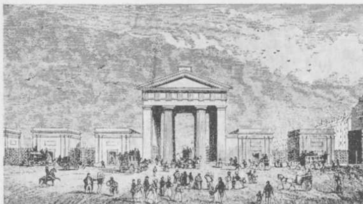
Ingang van het station Euston Square.
