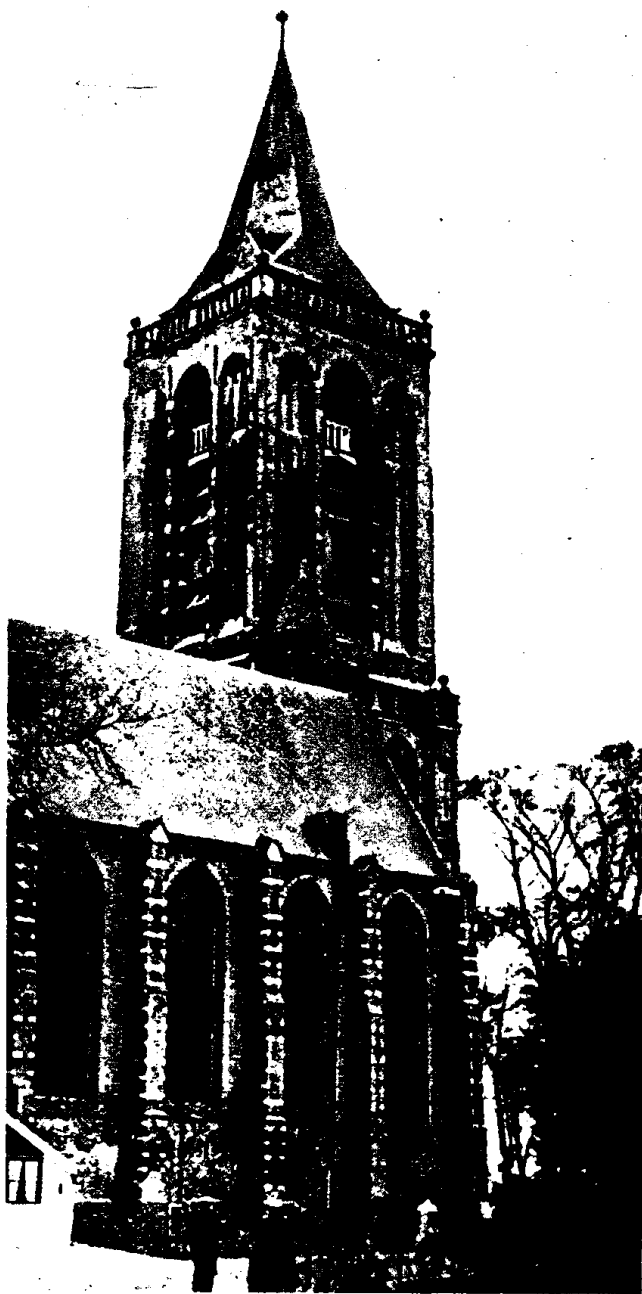
Met zijn zandsteenen banden, profielen en nissen is de zware toren het rijkst behandelde gedeelte van de kerk. De balustraden en de spits zijn 17de-eeuwsch, de romp ongeveer uit het begin der zestiende eeuw.
