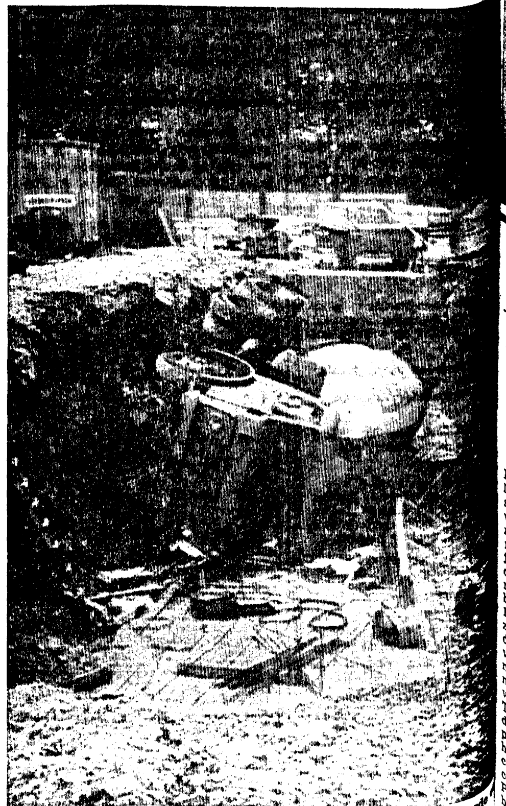
Bij werkzaamheden aan het Rigs-hospitaal in Kopenhagen manoeuvreerden betonnen rollen te onvoorzichtig aan de rand van een werkkuil.
