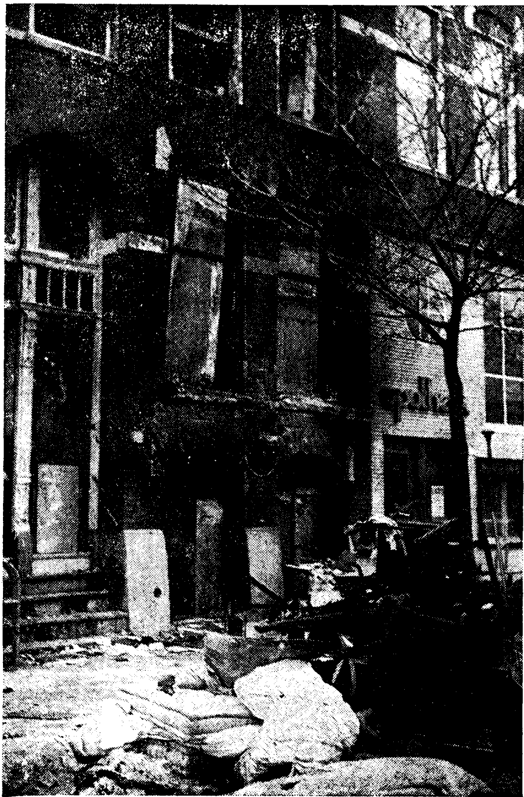
Een felle brand heeft op kerstavond aan vier bejaarden in Rotterdam het leven gekost. Van het pand brandde het souterrain en de beletage geheel uit; de eerste etage liep lichte brandschade op.
